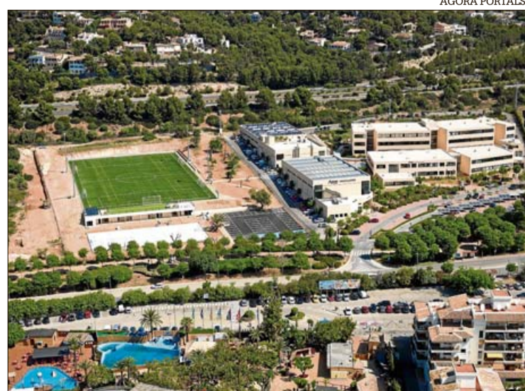
Conjunto de edificios con todas las instalaciones necesarias.
